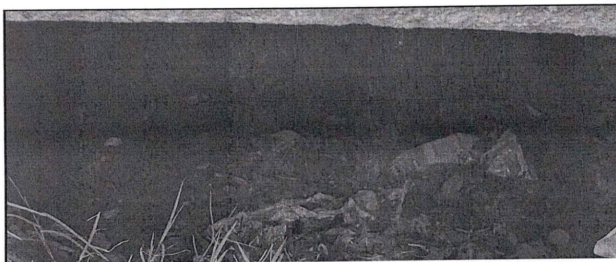
Imagem de dentro do bueiro.
