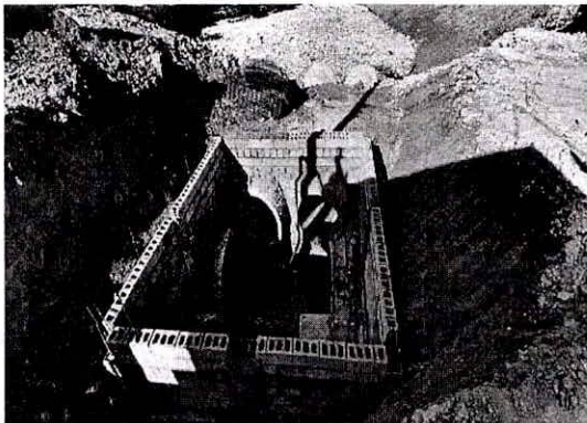
Interligação da rede existente com nova rede.
