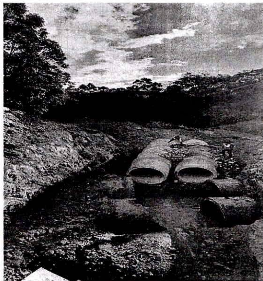
Implantação de nova rede de drenagem
