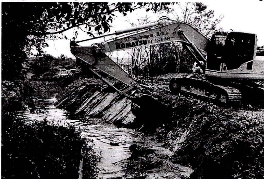
Limpeza na calha do Ribeirão dos Cristais
