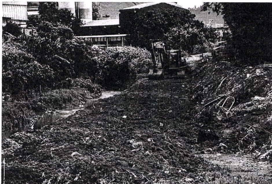
Limpeza na calha do Ribeirão dos Cristais
