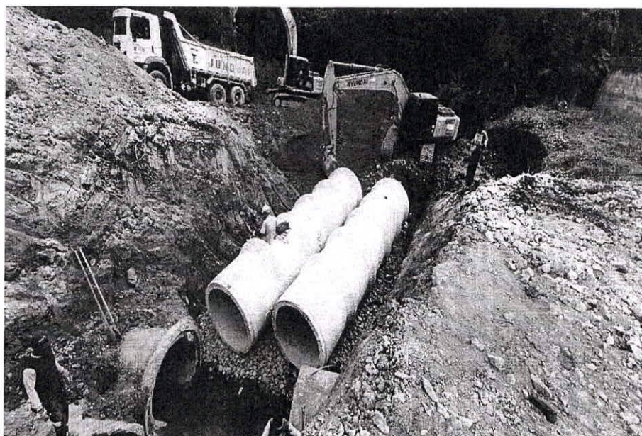
Implantação de nova rede de drenagem no ponto crítico "desmoronamento do muro"
