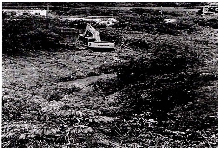
Limpeza na calha do Ribeirão dos Cristais
