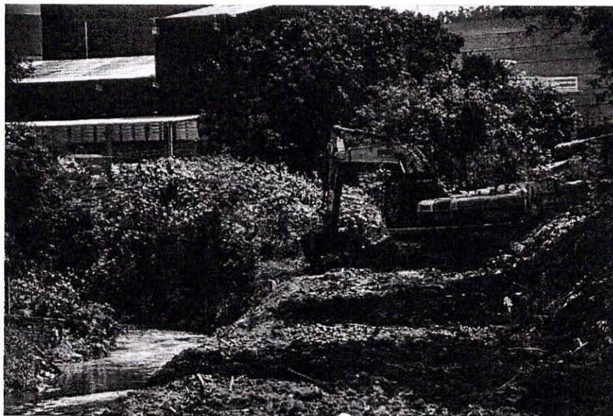
Limpeza na calha do Ribeirão dos Cristais
